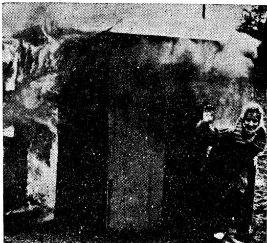
En la autopista del Oeste, en París, se ha probado un nuevo revestimiento líquido contra incendios que se aplica como una pintura y que puede resistir de 15 a 20 minutos una temperatura de 1.200 grados. En la foto, la casita que sirvió de experimento: la parte no tratada por el líquido contra incendios, a la izquierda, arde en unos segundos, mientras que la tratada, a la derecha, permite que la jovencita de la foto salga incólume y sonriente por la puerta.
